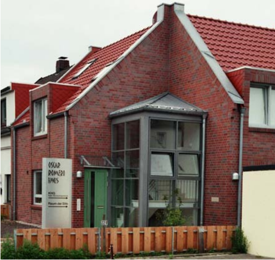
Abb. 67: Oscar Romero Haus in Oldenburg, Eingang zu den Studierendenzimmern.
