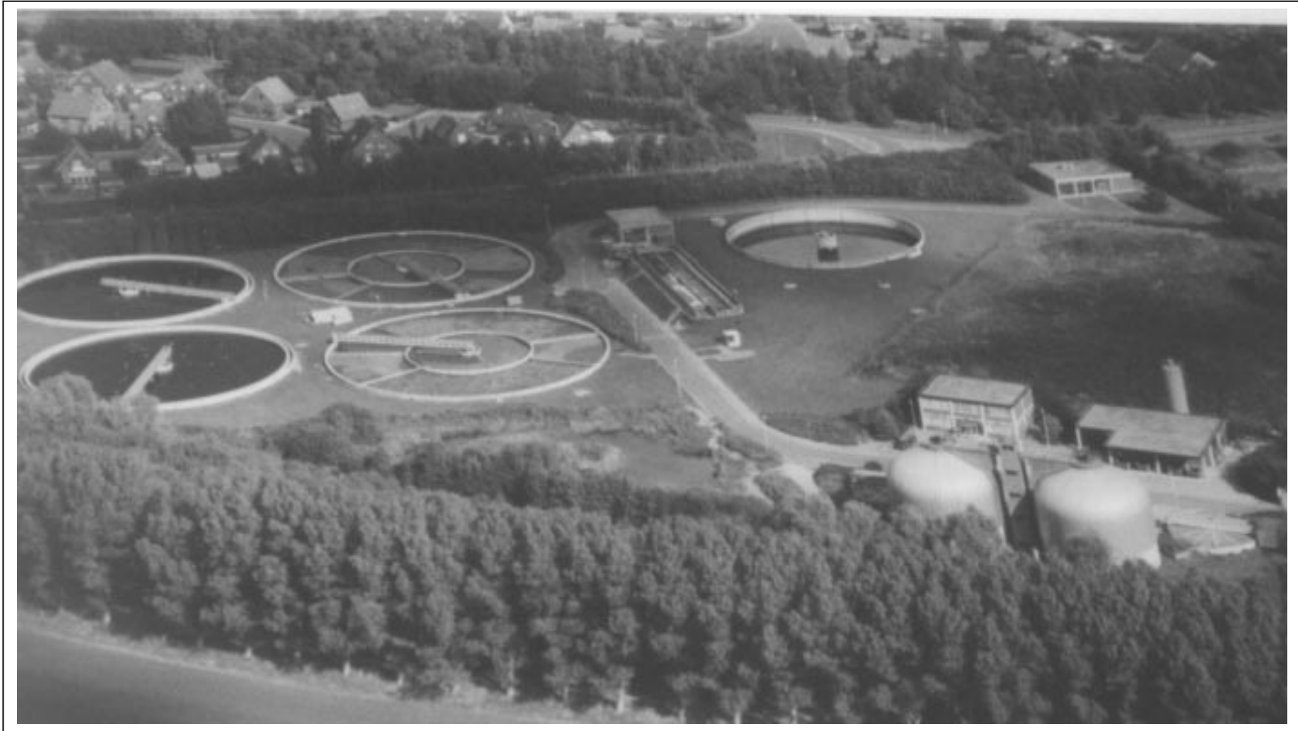
Abbildung 3: Luftbildaufnahme der Kläranlage Emden/Larrelt (Quelle: Kläranlage Emden/Larrelt).
