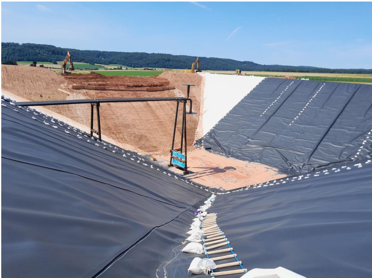
Abbildung 16: Bau des Erdbeckenspeichers in Bracht (Juli 2024)
