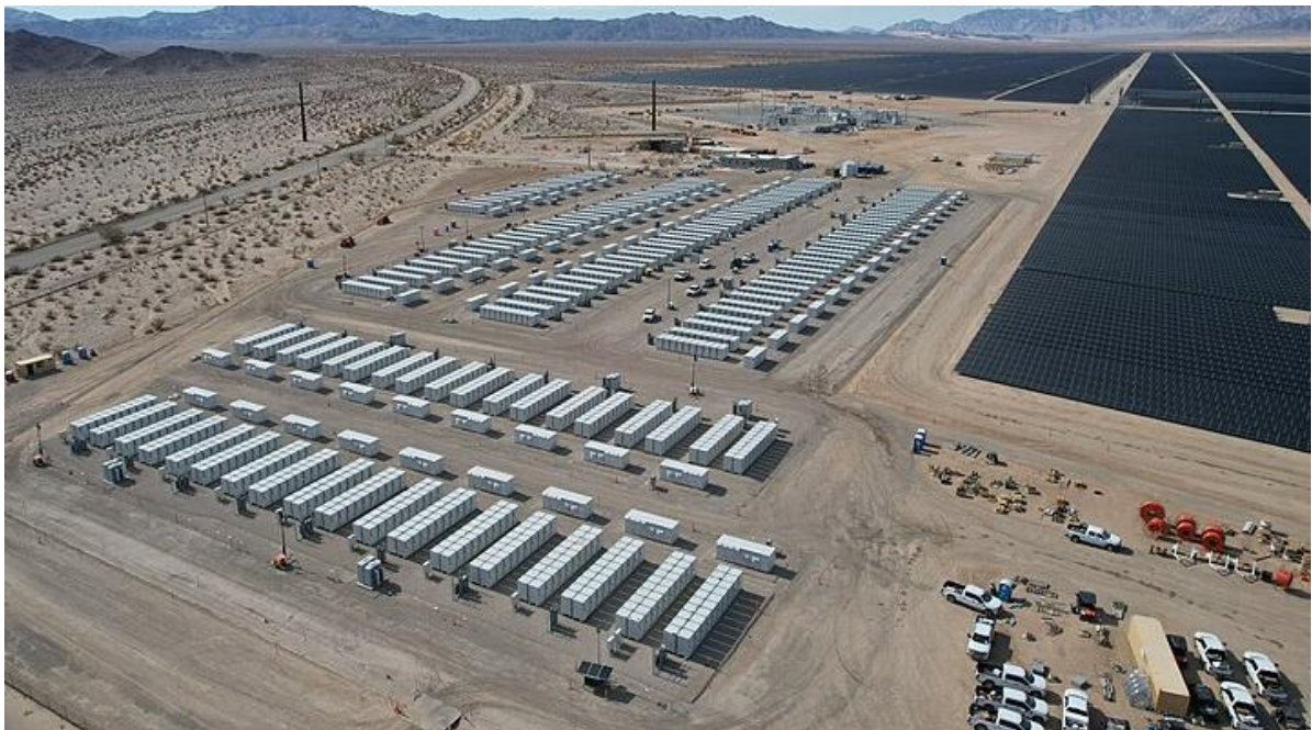
Abbildung 10: 300 MW Batteriespeicher in Kalifornien kombiniert mit Freiflächen Photovoltaikanlage
