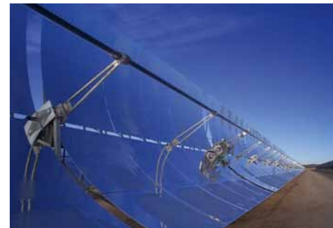
Abb. 14 Ein Segment des Solarfelds eines Parabolinnenkraftwerks: Im Brennpunkt des Spiegels verläuft die schwarze Receiveröhre, die in einer evakuierten Glashülle vor Wärmeverlusten geschützt ist.
