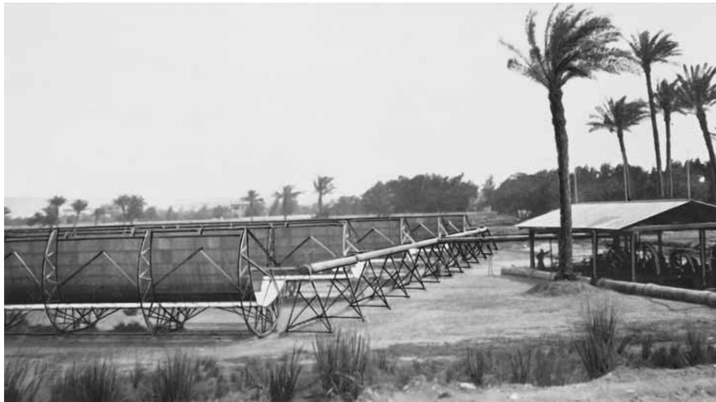
Abb. 9 Die Anlage von Shuman in Ägypten. Man sieht das Solarfeld mit fünf Segmenten und die Dampfleitung im Vordergrund, die zum Maschinenhaus mit der Dampfmaschine führt.
