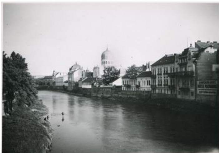
Die Kreisch in Großwardein, Aufnahme von September 1941 [Foto: Herder-Institut Marburg, Bildarchiv Nr. 216199].
