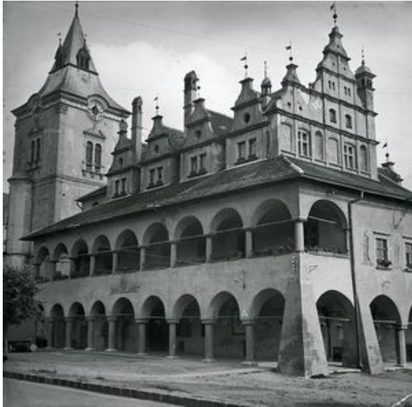
Rathaus Leutschau von Westen, 1555 erneuert nach einem Brand, vor 1945 [Foto: Herder-Institut Marburg, Bildarchiv Nr. 4d4694].
