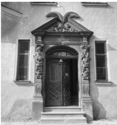
Portal am Bürgerhaus Schwartz in Narwa um 1941 [Foto: Herder-Institut Marburg, Bildarchiv Nr. 2a406].
