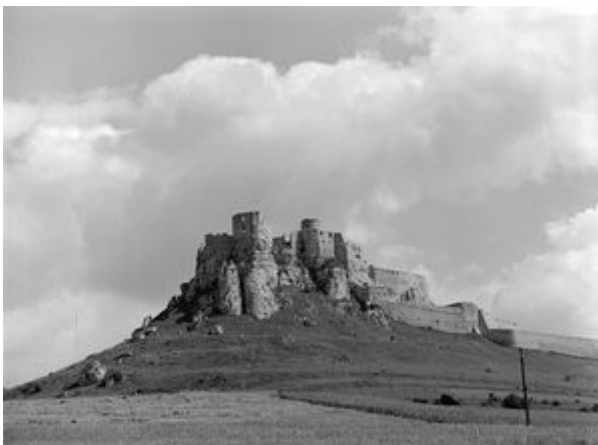
Zipser Burg bei Spišske Podhradie, erbaut um 1220/30, Umbau und Erweiterung im 14. und 15. Jahrhundert, 1987 [Foto: Herder-Institut Marburg, Bildarchiv Nr. 104801].
