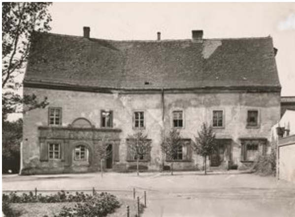
Das Piastenschloss in Haynau entstand um 1546. Das Foto zeigt die Ansicht von der Hofseite vor der Renovierung 1934. Danach war das Schloss Sitz des Heimatmuseums [Foto: Herder-Institut Marburg, Bildarchiv Nr. 72518].
