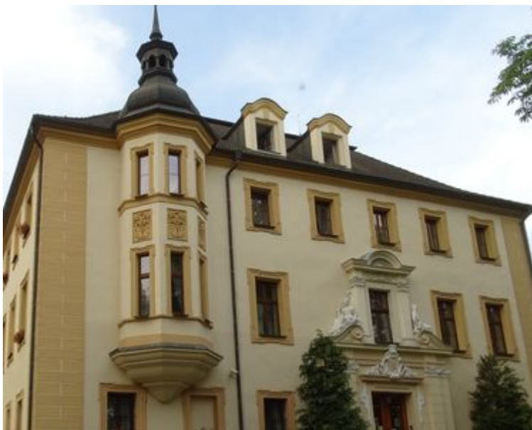
Rechts: nach der Renovierung [Fotos: Izabela Błaszczyk].
