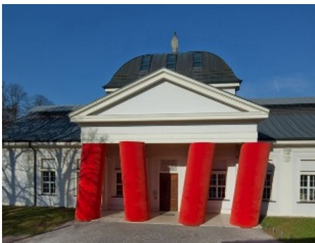
Kunstforum Ostdeutsche Galerie, Regensburg, Fassade mit Säuleninstallation von Magdalena Jetelová, Venceremos/Sale, 2006 [Foto: W. Schmidt].
