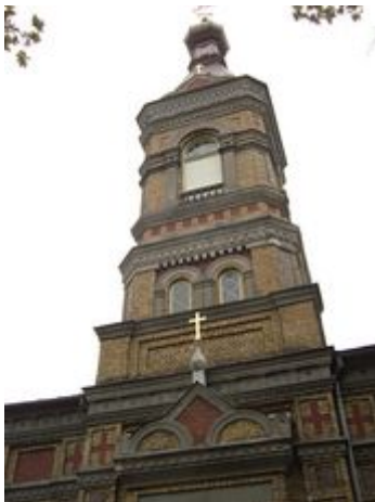
Turm der Christi Verklärungskirche.
