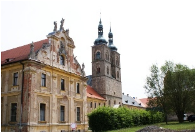
Prämonstratenserkloster Tepl/Teplá. Ansicht von Nordwesten [Foto: M. Bogade].
