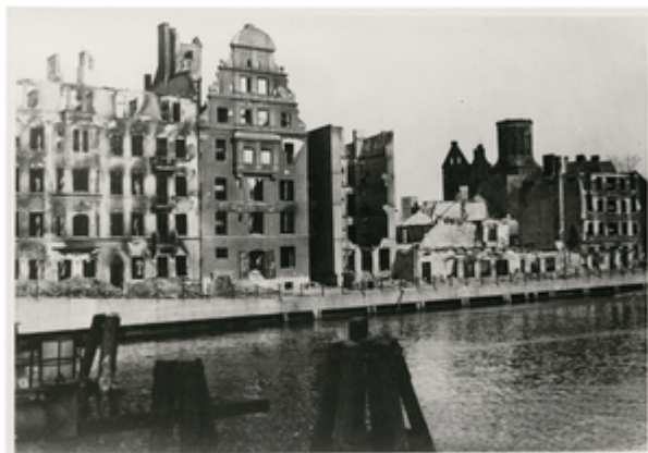
Kriegszerstörungen nach dem Luftangriff vom 27. August 1944: Hausruinen am Pregel mit dem Dom (Foto) [Herder-Institut, Marburg, Bildarchiv, Inv. Nr. 4c268].
