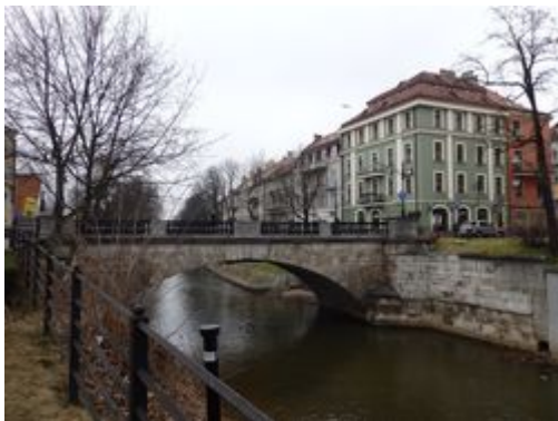
Die erste und älteste steinerne Brücke von Kalisch aus dem Jahr 1825 [Foto: Robert Kędzierski].
