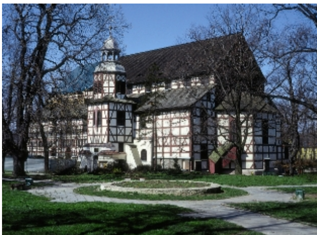
Die Friedenskirche in Jauer/Jawor (17. Jh.), seit 2001 eingetragen in die Liste des UNESCO-Weltkulturerbes. Die Sanierung des Fachwerks wurde u. a. aus Mitteln der Kulturförderung nach § 96 BVFG finanziert [Foto: U. Schaaf].
