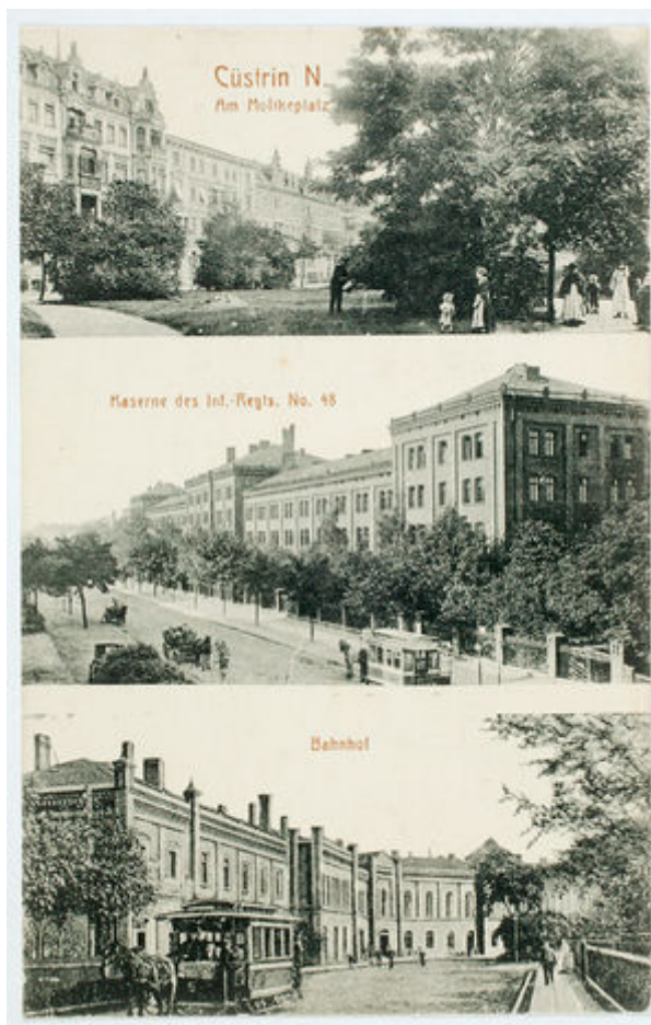
Stadtansichten Küstrin: Moltkeplatz, Kaserne, Bahnhof, Postkarte vor 1915 [Foto: Herder-Institut Marburg, Bildarchiv Nr. 99670].
