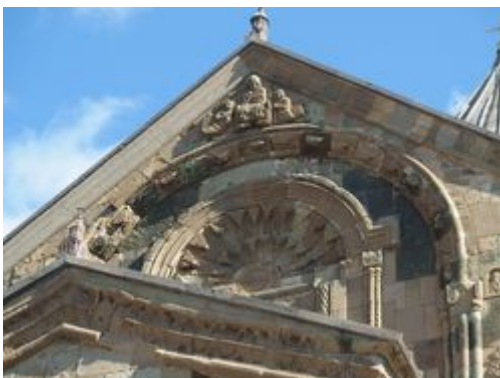
Detail des Reliefdekors der Westseite: thronender, von Engeln getragener Christus. Swetizchoweli ("Lebenspendende Säule")-Kathedrale in Mzcheta [Foto: Alexandra Cappel].
