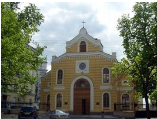
Gegenwärtiger Zustand nach der Restaurierung
