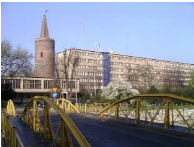
Der mittelalterliche Turm des Piastenschlosses und das 1930-1934 errichtete Regierungsgebäude der Provinz Oberschlesien, heute Woiwodschaftsamt. [Foto: B. Störtkuhl]
