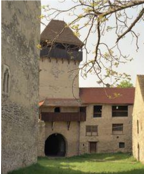
Innenhof mit Torturm.
