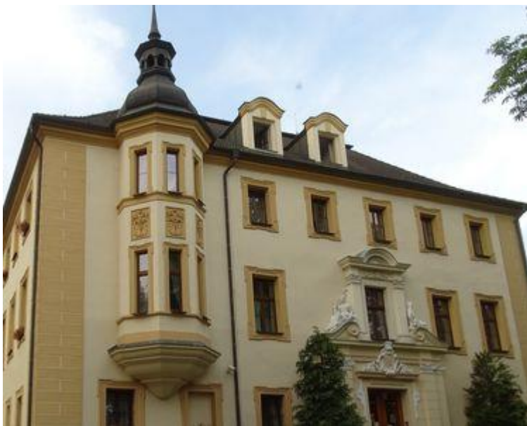
Rechts: nach der Renovierung [Fotos: Izabela Błaszczyk].
