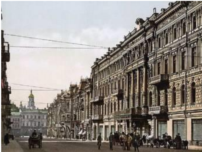
Hotel Continental, erbaut 1895-1897 von Eduard Bradtmann und Georg Schleifer. Heute wird das Gebäude von der Nationalen Kunstakademie der Ukraine genutzt. Foto um 1900 [ http://starkiev.com ].
