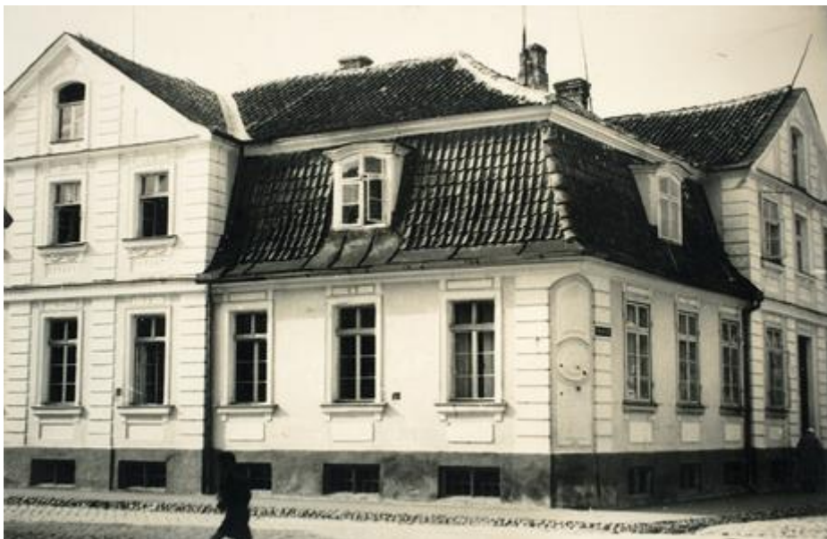
Buchdruckerei Steffenhagen im Haus Raina iela 12 (Grünhofsche Straße/Ecke Kannengießer Straße) in Mitau um 1938
