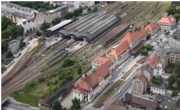
Heutiges Bahnhofsensemble (Neubau 1914-1917) und Bahnanlagen. [Foto: Andreas Bednarek].
