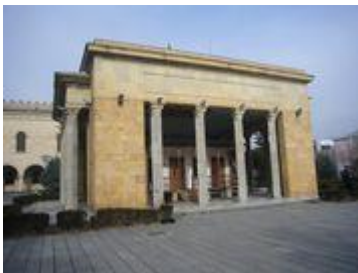
Geburtshaus von Stalin in Gori mit "Mausoleums"-artigem Überbau [Foto: Alexandra Cappel].
