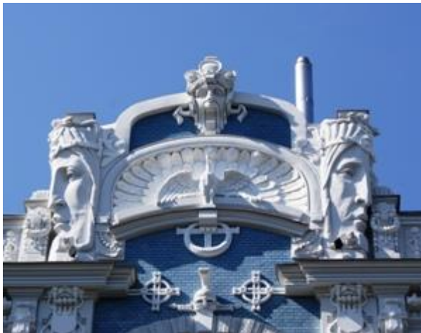
Detail einer Jugendstilfassade in der Elizabetes iela 10b, erbaut von M. Eisenstein 1903. [Foto: M. Bogade]
