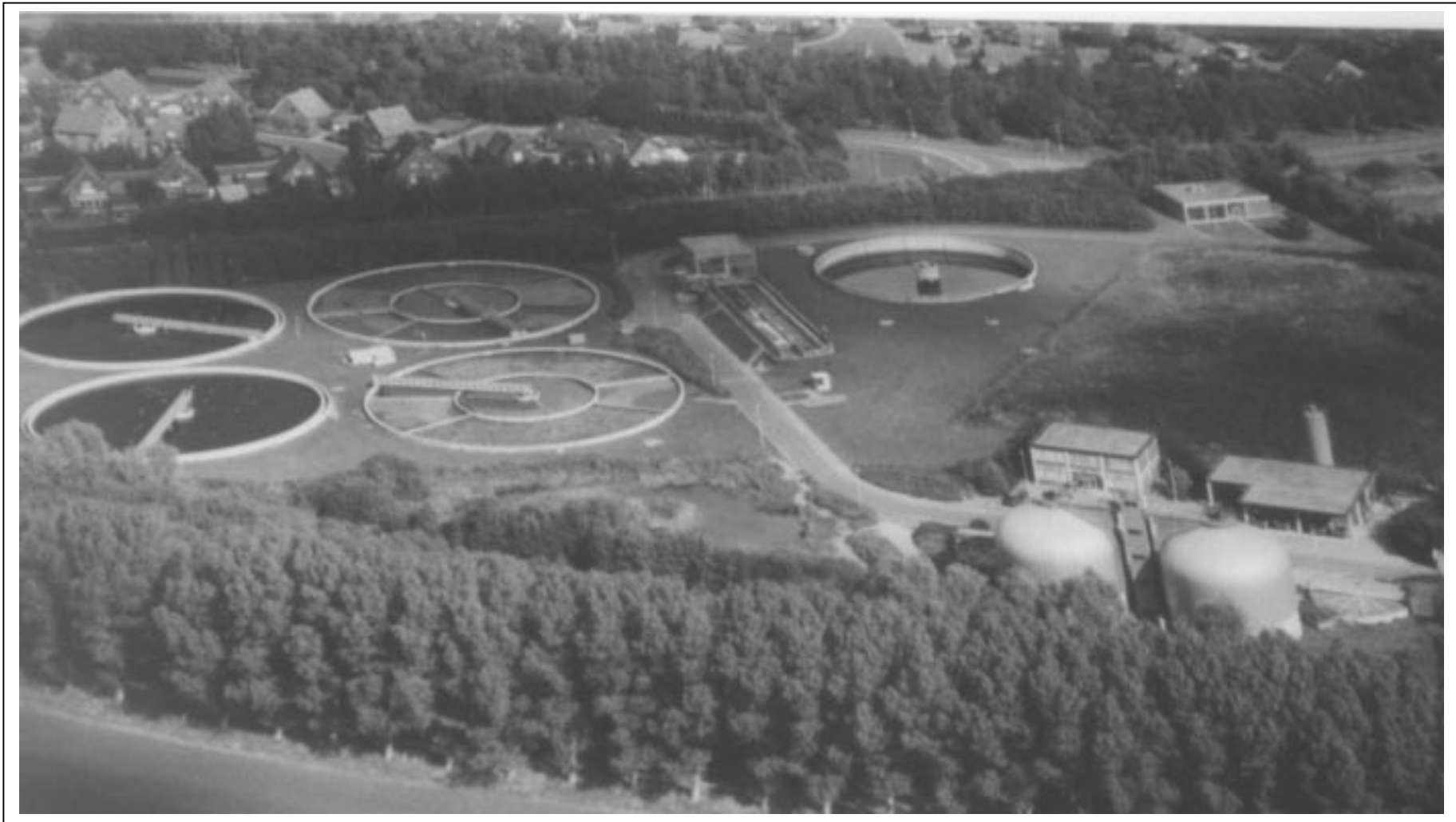
Abbildung 3: Luftbildaufnahme der Kläranlage Emden/Larrelt (Quelle: Kläranlage Emden/Larrelt).
