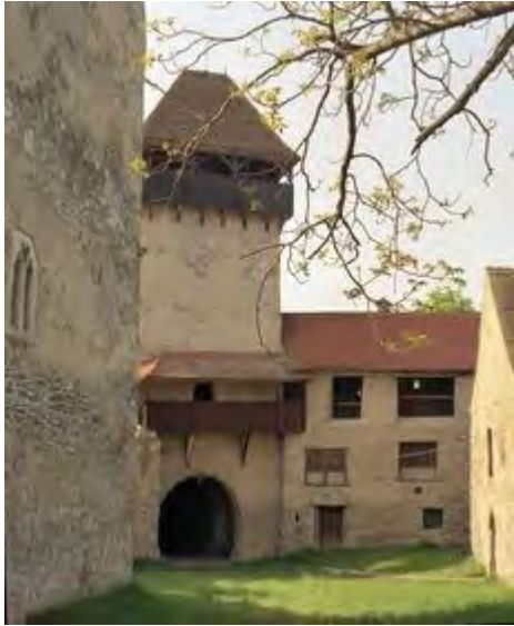
Innenhof mit Torturm.
