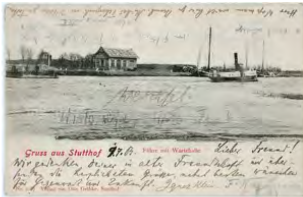
Stutthof Fähre und Wartehalle [Herder-Institut Marburg, Bildarchiv Nr. 145137].
