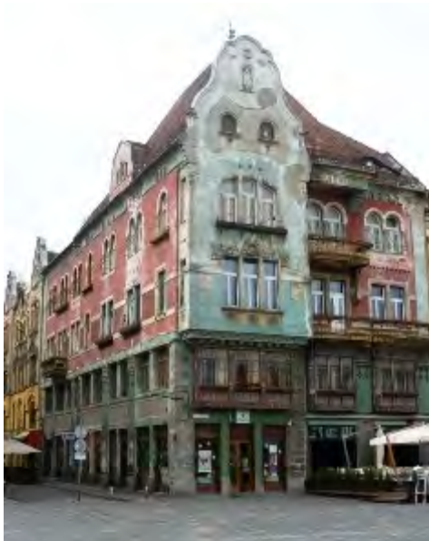
Ein typisches Wohngeschäftshaus im Sezessionsstil an der Südseite des Domplatzes (Foto: 2008) [© H. Rieser].
