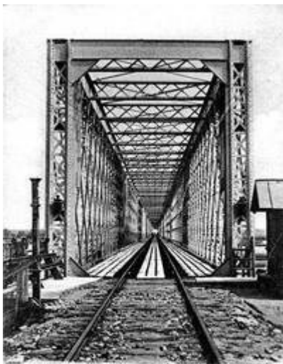
Железнодорожный мост. — Le pont de chemin de fer. N. M. Kiew. — Kiew
