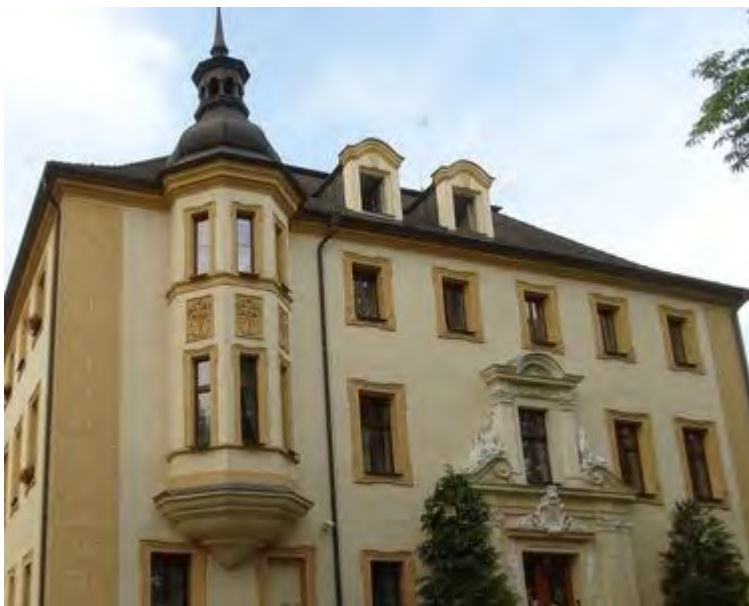
Rechts: nach der Renovierung [Fotos: Izabela Błaszczyk].
