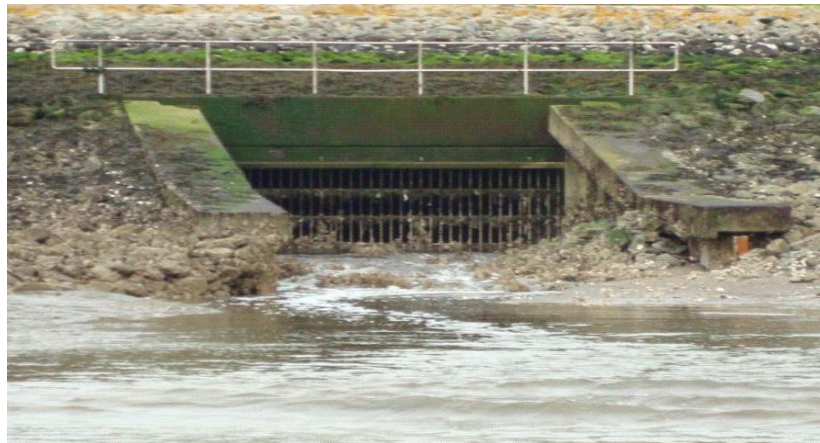
Abb. 36: Die Mündung der Abwässer aus der Zentralkläranlage am Heppenser Groden.
