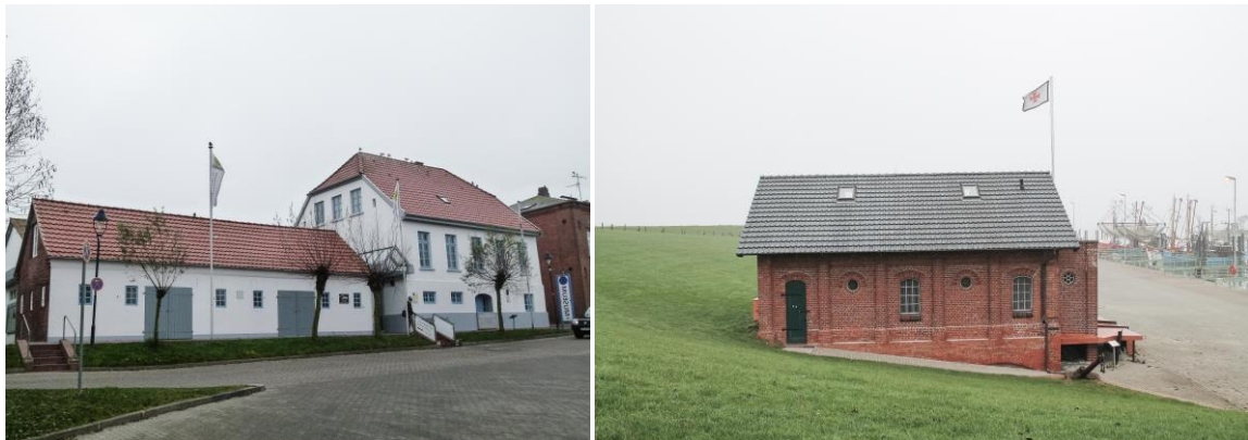
34 Das Nationalpark-Haus Museum Fedderwardersiel und der dazugehörige Seenotrettungsschuppen.
