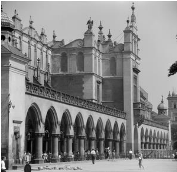
Abb. Ostfassade der Tuchhallen Krakau, [Foto: Stefan Arczyński, Herder-Institut Marburg, Bildarchiv Inv.Nr. 301269].
