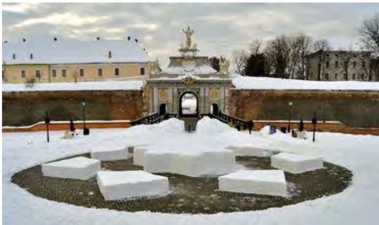
Drittes Tor der Burg. Im Vordergrund: ein Schneelabyrinth in Form der Alba Carolina Burg (Sternform mit sieben Ecken) mit den sieben Bastionen [Foto (Februar 2012): Cornelia Guju].
