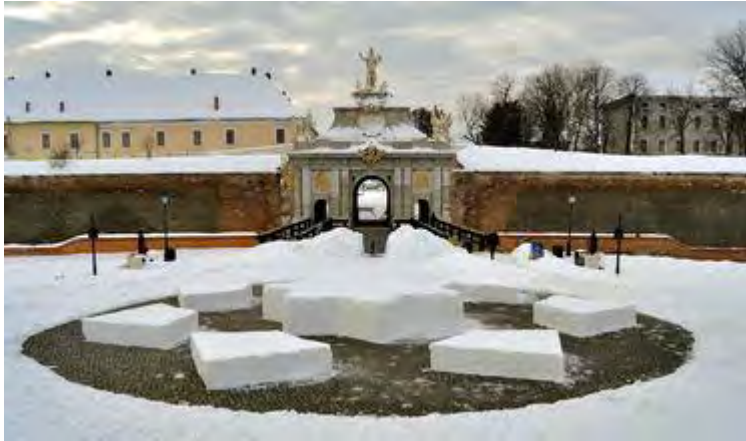
Drittes Tor der Burg. Im Vordergrund: ein Schneelabyrinth in Form der Alba Carolina Burg (Sternform mit sieben Ecken) mit den sieben Bastionen [Foto (Februar 2012): Cornelia Guju].
