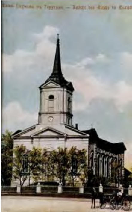
Kirche in Tarutino, erbaut 1862-1865, größter Kirchenbau der ev.-luth. Gemeinden in Bessarabien für bis zu 2000 Personen (kolorierte Postkarte); 1941 zerstört, heute steht ein anderes Gebäude auf dem Platz.
