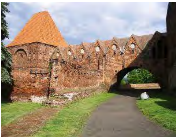
Der Dankser (Abortturm) an der Ruine der Deutschordensburg in Thorn/Toruń. [CC BY-SA 3.0/ T. Weger]
