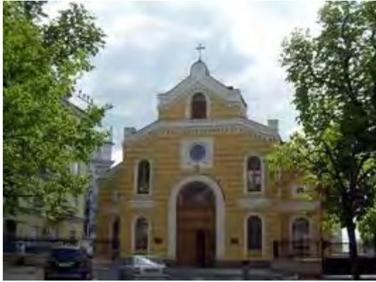
Gegenwärtiger Zustand nach der Restaurierung
