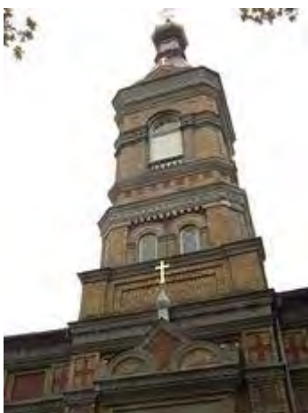
Turm der Christi Verklärungskirche.
