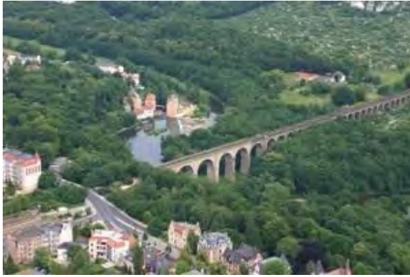
Luftbild des 1846 eröffneten Neiße-Viadukts, das heute zum Anlagenvermögen der polnischen Staatsbahn gehört. [Foto: Andreas Bednarek].
