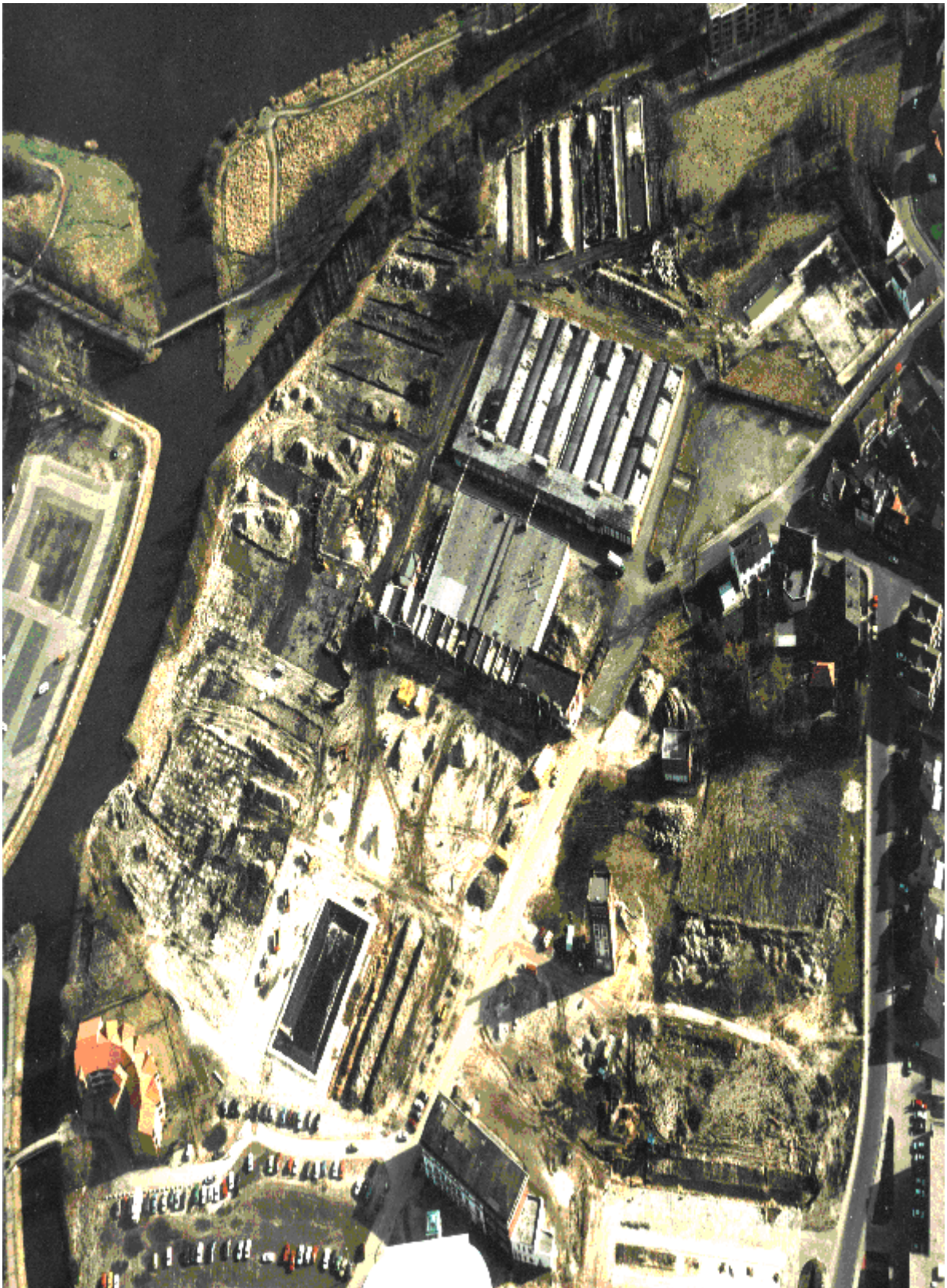
FOTO 9: WEITERE ABRISS- UND SORTIERUNGSARBEIT 1985
