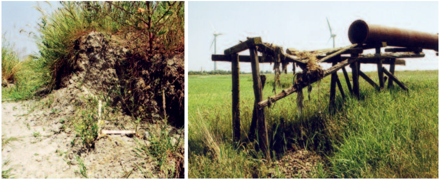
Abb. 9: Wybelsumer Polder 2005. Abbruchkante an einem Spüldeichdurchbruch (links). Ende einer Spülrohr-Leitung mit Holzgerüst (rechts).
