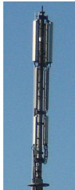
**Abbildung 2.4:** Antennen eines BTS-Turms
