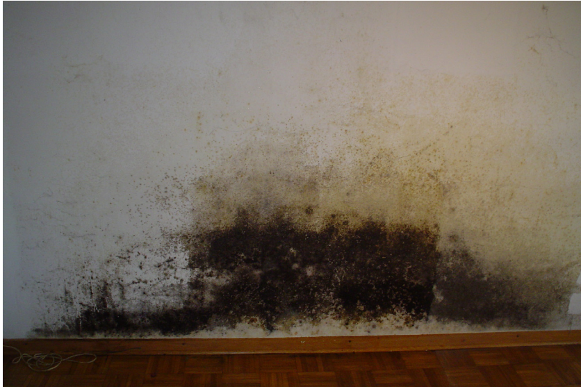
Abbildung 32: Ansicht einer mit Schimmelpilzen befallenen Tapete auf einer Außenwand
