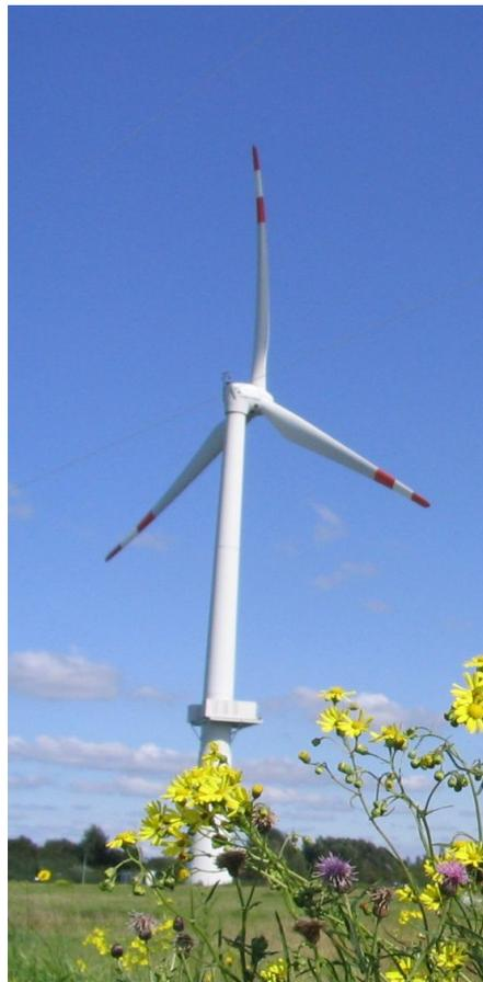
Abbildung 5.1: Prototyp der AREVA M5000 Windenergieanlage mit einer Nennleistung von 5 MW, an der die Lidarmessungen durchgeführt wurden. (Foto: David Schlipf)
