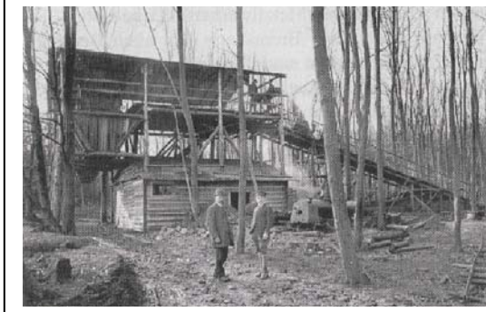
Abb. D 1-7: Grubengebäude im Buchholz.
